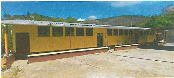
Foto 2: Colocación de pintura corona clásica color blanco antiguo y rojo teja, en aulas existentes.
