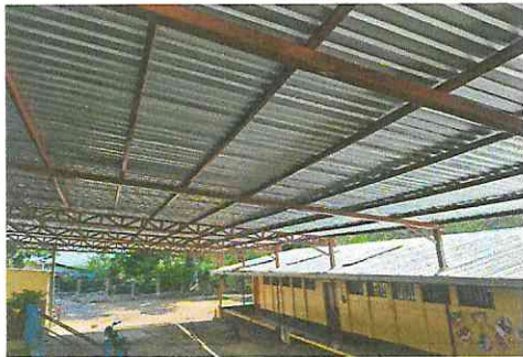
Foto 1: Tejado con estructura metálica y lámina troquelada calibre 26 en patio frente a las aulas.
